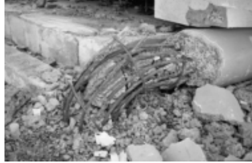
Bild 3: Um das Erdgeschoss abgesackte 2-stöckige Bürogebäude im Hafen von Kandla (linkes Bild) und Überreste der Erdgeschossstütze an der Ecke des Gebäudes (rechtes Bild)
