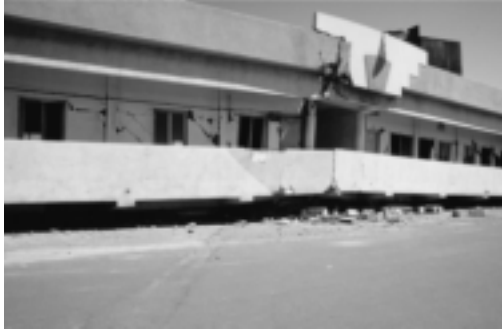
Bild 3: Um das Erdgeschoss abgesackte 2-stöckige Bürogebäude im Hafen von Kandla (linkes Bild) und Überreste der Erdgeschossstütze an der Ecke des Gebäudes (rechtes Bild)
