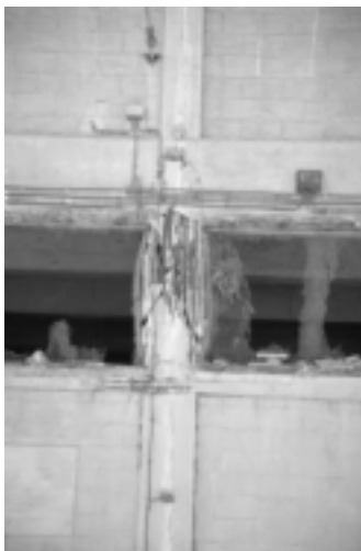
Bild 1 (links): Versagen der kurzen Stützen einer Lagerhalle im Hafen von Kandla
