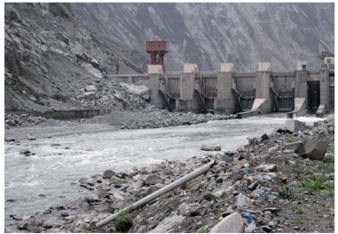
Bild 4. Wehr des Flusskraftwerkes Futan.
