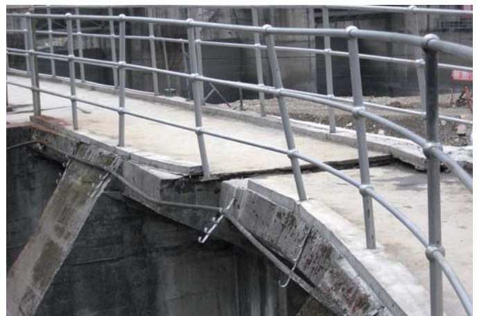
Bild 8. Yingxiuwan: Differentielle Bewegungen an Gehstegfugen.
