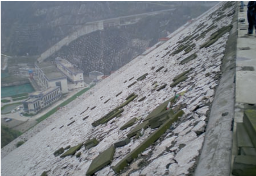
Bild 3: Luftseite des Zipingpu-Schüttdamms mit Bruchstücken des Geländers (April 2009)
