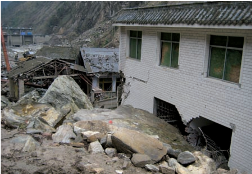
Bild 1: Felssturz auf dem Kraftwerksareal der Shapai-Stauanlage (April 2009)
