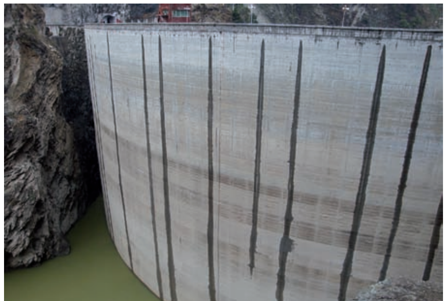
Bild 4: Wasserseite der Shapai-RCC-Bogenmauer bei abgesenktem Stausee (April 2009)
