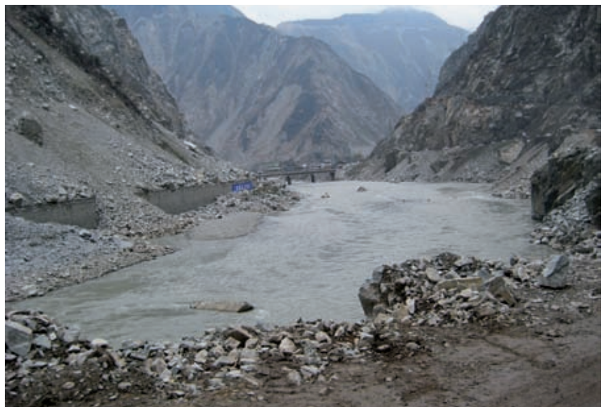
Bild 2: Unterbrochene Verkehrswege infolge Erdbeben und Steinschläge (April 2009)
