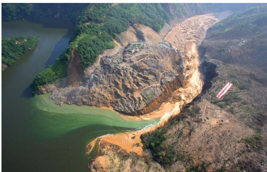
Bild 11. Tangjianshan-Erdbebensee wird durch künstlich geschaffene Hochwasserentlastung auf einem sicheren Niveau stabilisiert.
