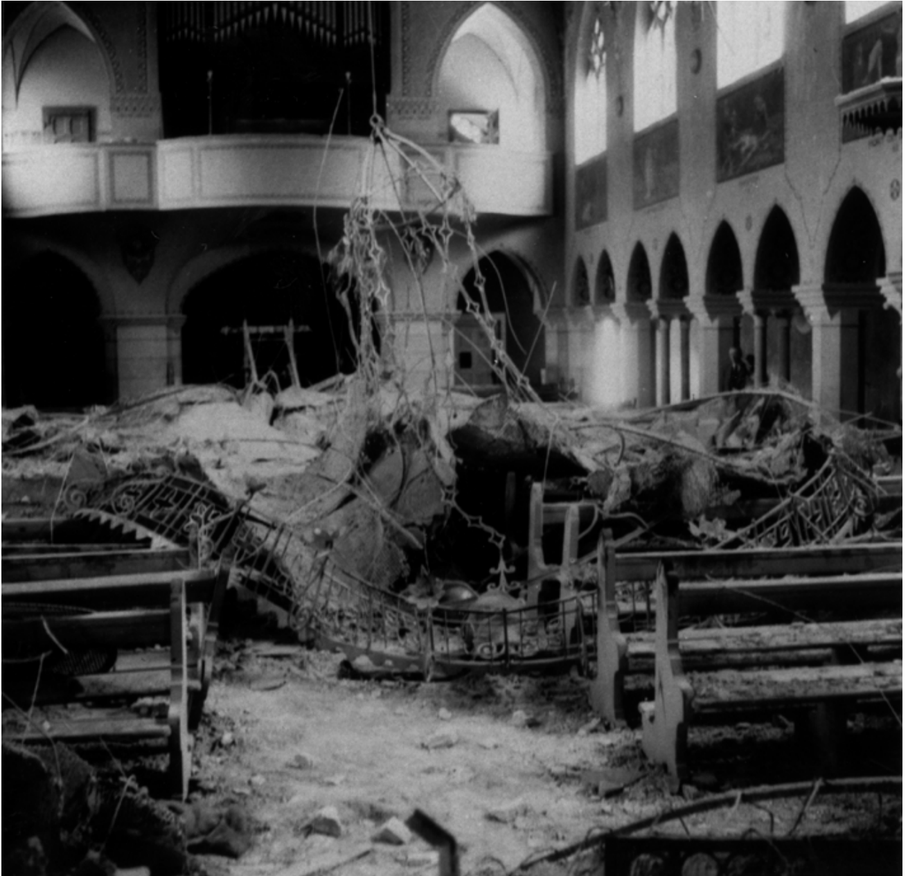
Figure: Plafond effondré de l'église de Chippis en Valais après le séisme de 1946. Source: Fotopress Zürich
