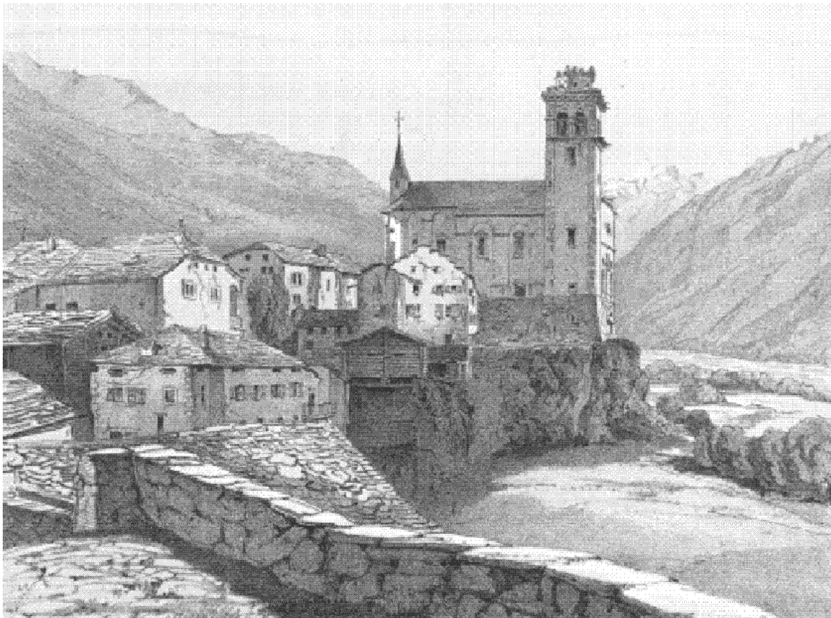
Historische Abbildung der Erdbebenschäden in Visp 1855: Viele Hausmauern sind von Rissen durchzogen und die Spitze des Kirchturmes ist eingestürzt.
