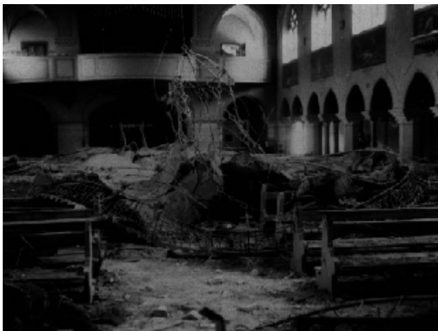
Bild 1: Abgestürzte Decke in der Kirche von Chippis nach dem Walliser Erdbeben von 1946 (Quelle: Fotopress Zürich)
