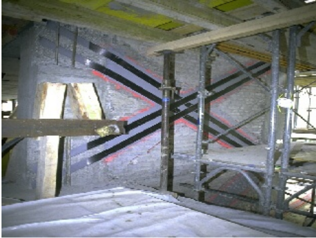
Bild 2 Nachträgliche Erdbebensanierung einer Mauerwerkswand mit kreuzweise aufgeklebten Kohlefaserlamellen beim Umbau eines Geschäftshauses in Zürich (Quelle: ETH Zürich)
