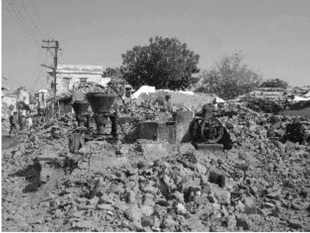
5. Total zerstörte Mauerwerksbauten in Indien, Gujarat, Indien Januar 2001
